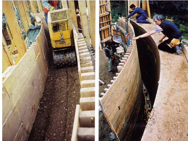
Abb. 7.1-2) zu 1: Stampflehm in Ekuador (Minke, G.: Lehmbau - Handbuch , Ökobuch 1997) / zu 2: Stampflehm in Europa (Nieden, Ziegert: Neue Lehm – Häuser international , Bauwerkverlag 2002)
