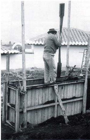
Abb. 7.1-2) zu 1: Stampflehm in Ekuador (Minke, G.: Lehmbau - Handbuch , Ökobuch 1997) / zu 2: Stampflehm in Europa (Nieden, Ziegert: Neue Lehm – Häuser international , Bauwerkverlag 2002)
